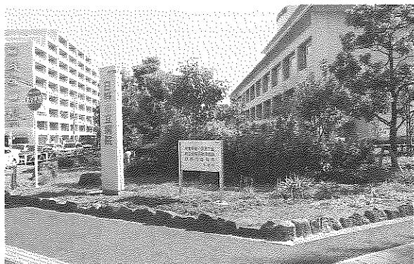
〔市立病院〕北西角
